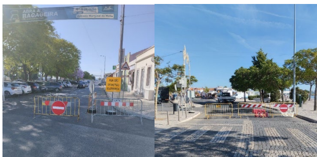
Suspensão do trânsito na Av. Marginal
