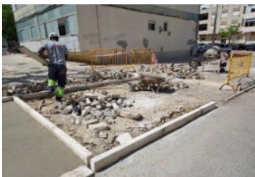
Imagem 9 – Trabalhos de abertura de gare
