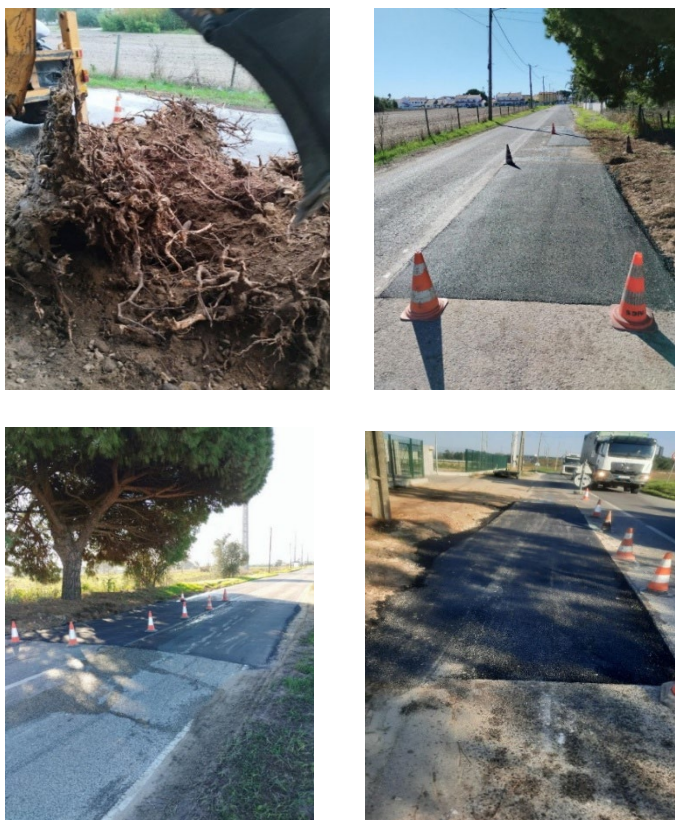
Rua Agostinho Neto, Penteado e Estrada de Sarilhos, G.R.S.P. Repavimentação após remoção de raízes
