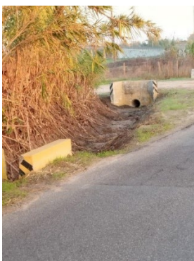
Limpeza de Aquedutos
