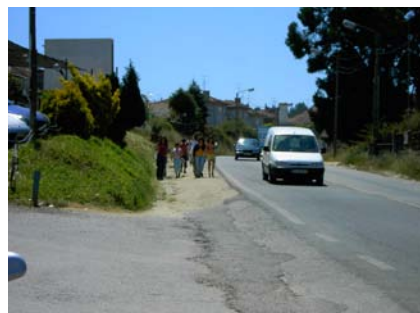
Ausência de passeio, Santarém
