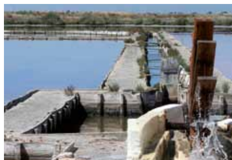
Engenho para abastecimento de águas à salina (Fotografia: Câmara Municipal de Alcochete)
